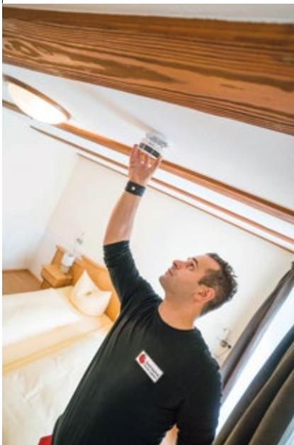
Die Elektroinstallateure von LS Elektrotechnik haben in jedem der Gastzimmer Rauchwarnmelder Genius Plus X installiert
