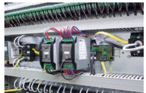
An das USV-Modul werden externe Bleiakkus mit einer Kapazität von bis zu 40 Ah angeschlossen, das ermöglicht lange Überbrückungszeiten.
